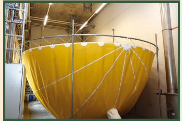
Auffangballon für genutztes CO 2 -Gas. Ist der Ballon komplett gefüllt, wird das Gas wieder in den Arbeitskreislauf geleitet. Collector for used CO 2 gas. Once the collector is completely filled, the gas is fed back into the process circuit.
